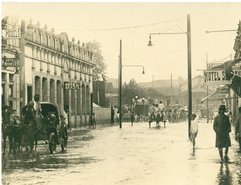
Figura 10 – Alagamento em frente à estação da Mogiana
