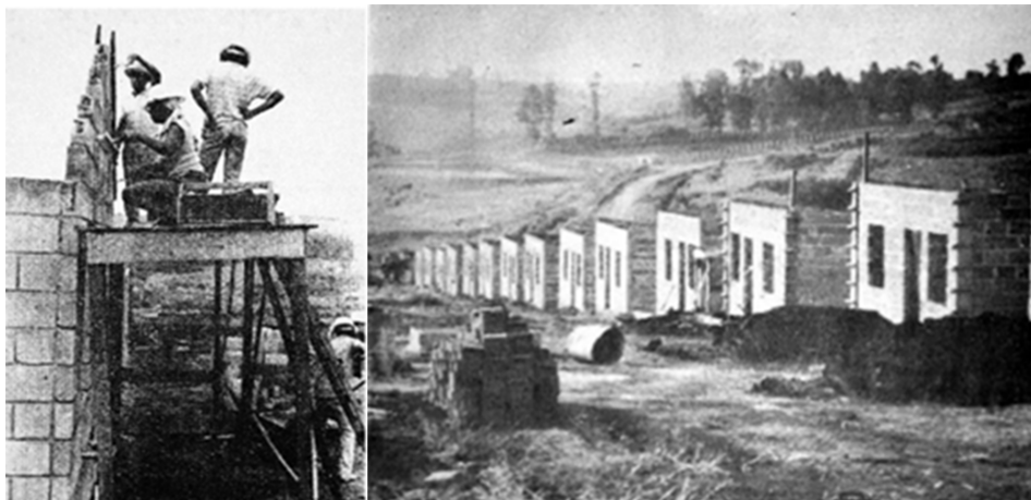
Figura 06 - Construção em mutirão das casas do Santa Felicidade com mutirão
