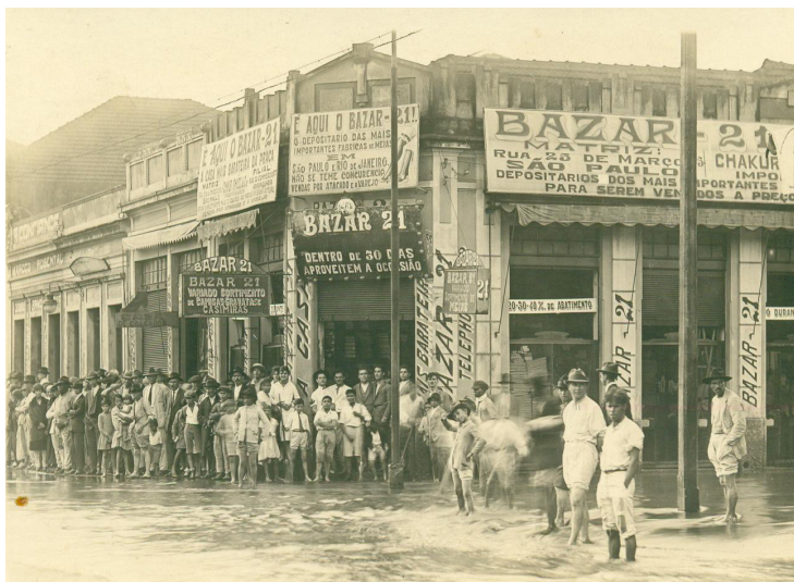
Figura 12 – Alagamento na Rua Jerônimo Gonçalves, que margeava a estação da Mogiana
