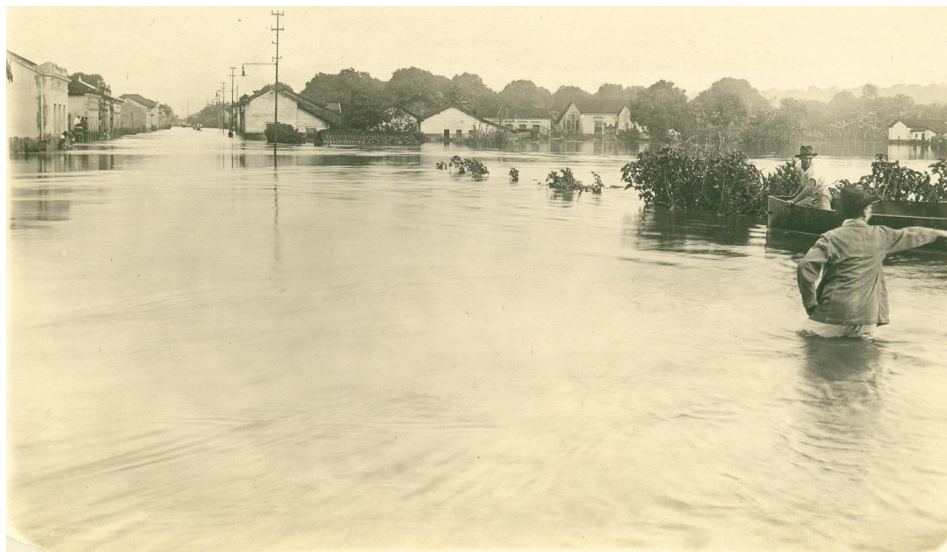
Figura 14 – Alagamento na Rua Jerônimo Gonçalves, em frente à estação da Mogiana
